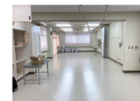
栃木県臨時医療施設 床張り替え
